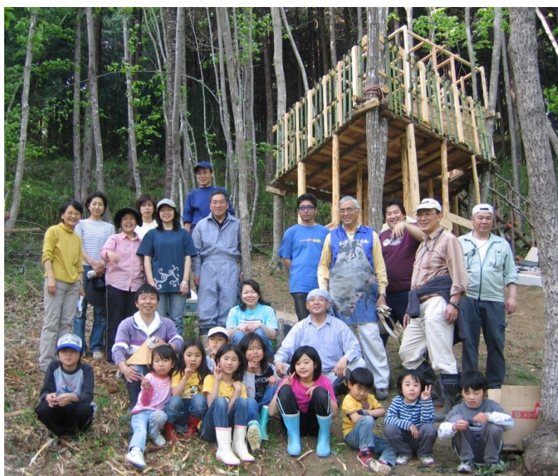
2009 年 5 月 第 1 棟目のツリーハウスが完成
